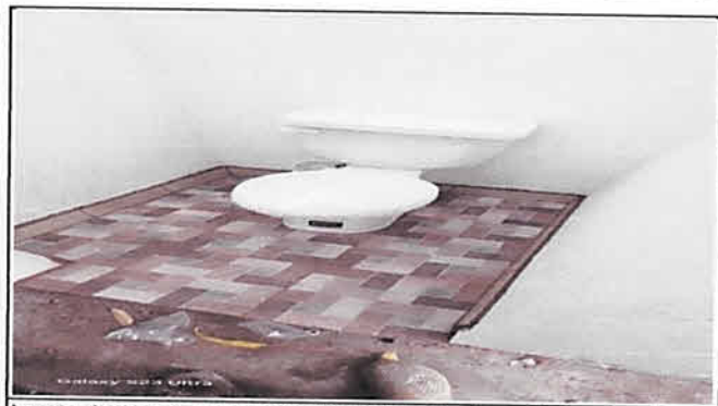
Levantado de pared para sanitarios, instalación de sanitarios, drenaje e instalación de piso cerámico antideslizante.
