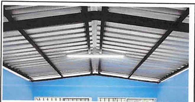
Reparación de sistema eléctrico.
