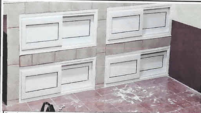
Sustitución de piso liso por piso cerámico.
